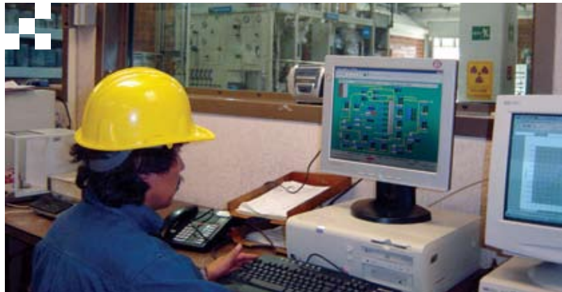
Escalamiento de tecnologías e información para el diseño de ingeniería básica de proceso y desarrollo de procedimientos operativos, analíticos y de control para los trabajos de refinación y petroquímica, metodologías creadas por el IMP
